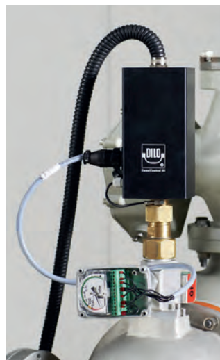
Соединительная коробка монитора плотности в собранном состоянии
