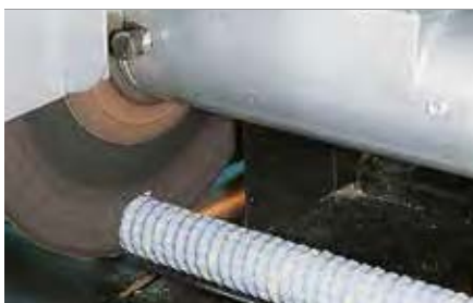
Schlauch im rechten Winkel unter der Trennscheibe fixieren Position conduit below cutting disc (90°)
