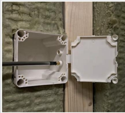
Senkkopfschrauben mit Deckel können beliebig durch die Seitenwände des Einlasskastens geschraubt werden.
