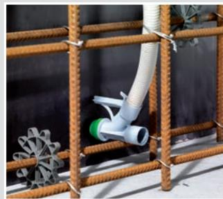
Die umlaufende Rohrsicherung hält das Rohr fest in der Aufnahme und sichert somit ein funktionierendes Leerrohrsystem.
