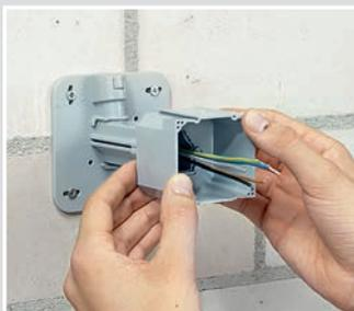
Einlasskasten bis zum Anschlag auf den Trägerarm aufsetzen.
