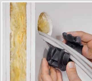
Den zweiteiligen Schottzylinder um die Leitungen legen und zusammendrücken.
