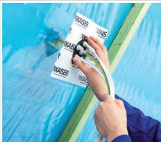
Die werkzeuglose Leitungs- oder Rohrdurchführung der ECON®- Technik bietet maximalen Installationskomfort und ermöglicht eine schnelle Verarbeitung.
