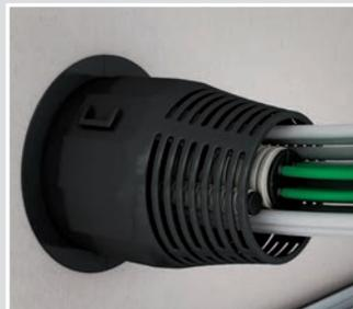
Mischbelegung von Leitungen und Rohren.
