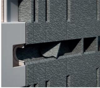
Für ein zusätzliches Rohr können die Stege bei den Neopor-teilen entfernt ...
