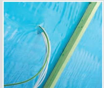
Die Leitungen werden durch die Luftdichtung des Gebäudes geführt. Diese Durchführung muss dauerhaft luftdicht verschlossen werden.
