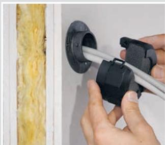
Dichtelement um die Leitungen legen und verschliessen.
