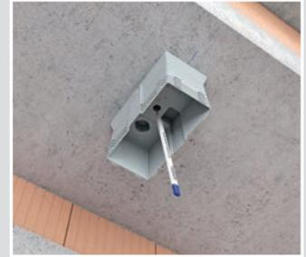
Alternativ: Einbaugehäuse mit den Ausrichtmarkierungen für die Leuchte positionieren und Bohrloch anzeichnen.
