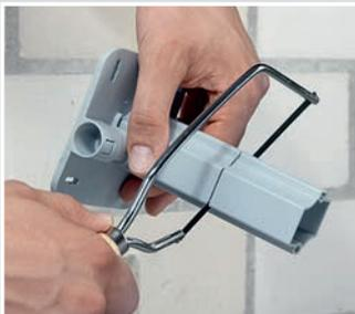
Träger durch Absägen auf benötigte Länge kürzen, integrierte Massangabe sorgt für exaktes Ablesen des Masses.
