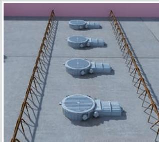
Erstelltes Fertigteilelement mit integrierten HaloX-Gehäusen.
