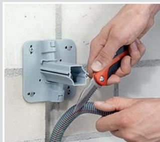
Das Installationsrohr an die Rohreinführung am Grundträger anpassen und abschneiden.
