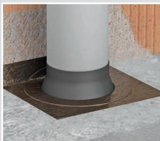
Vor dem Anpressen des Klebekragens den Primer bis zur Transparenz ablüften lassen. Eingedickter Primer kann mit Wasser verdünnt werden.
