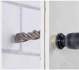
Die Installationsöffnungen können mit handelsüblichen Bohrern (20 mm bzw. 32 mm) in der massiven Wand oder in der Trockenbauwand mit einem Bohrer oder dem Fräser 1082-10 (35 mm) erstellt werden.
