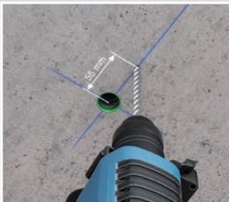
Ein Loch  $\varnothing$  8 mm für Standarddübel bohren und Dübel setzen.
