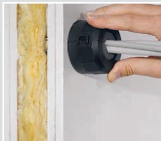
Dichtelement auf den Schottzylinder setzen und mit einer 1/4-Drehung befestigen (Bajonetverschluss).
