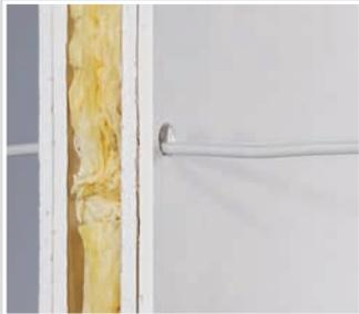
Installationsöffnung  $\varnothing$  20 mm mit einem Fräser (z. B. KAISER-Hartmetallfräser 1088-06) oder einem Bohrer erstellen.
