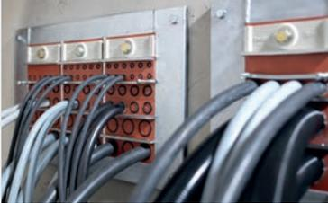
Die **Modul-Abschottungssysteme von BST** dienen zur Abdichtung von Kabeln, Rohren und Stromschielen in Wand- und Deckendurchbrüchen von Gebäuden, Schiffen und Stahlkonstruktionen. Die halogenfreien Elastomer-Kunststoff-Module schützen jede Leitung zuverlässig vor Feuer, Wasser, Rauch, Gas, statischen und dynamischen Druck. **Das ermöglicht geringen Wartungsaufwand und geprüfte Sicherheit.**
