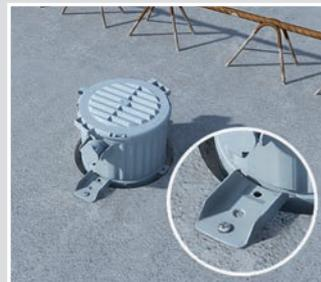
Gehäuse aufstecken und in die Kernbohrung setzen, anzeichnen und befestigen. Rohr in Kombinationseinführung M20/ M25 installieren.
