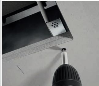
Gehäuse mit Schnellbauschrauben an der Brandschutzdecke befestigen...
