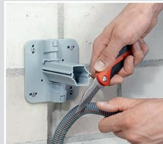
Das Installationsrohr an die Rohreinleitung am Grundträger anpassen und abschneiden.
