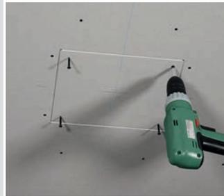
...anschliessend den zuvor erstellten Ausschnitt anfasen und mit Schnellbauschrauben befestigen.
