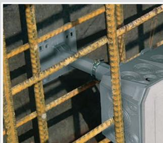
Wandstärke bis 20 cm: 8-Kant-Rohr an Sockel und Trägerplatte auf das passende Mass kürzen. Wandstärke 20 bis 25 cm: Teleskop-Abstützung auf das passende Mass einstellen.
