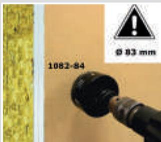
Installationsöffnung Ø 83 mm mit einem Fräser (z. B. Bi-Metall-Fräser 1082-84) erstellen.
