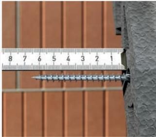
Der Dübel muss den Aufbau des Geräteträgers je nach Dübellänge um min. 30 mm überragen.
