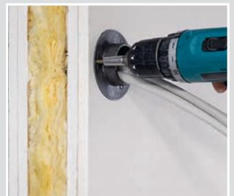
Befestigung, wie bei Hohlwanddosens, durch das Anziehen der Laschenschrauben.
