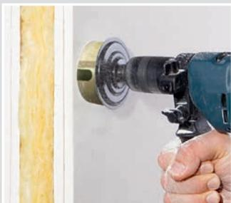
Installationsöffnung mit einem Ø 74 mm Fräser (z.B. Multi 4000: 1084-10) erstellen.
