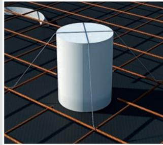
Mit Rödeldraht den Schalungskörper an der Bewehrung fixieren.
