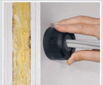
Dichtelement um die Leitung fügen, verschliessen und durch eine 1/4 Rechtsdrehung fixieren.
