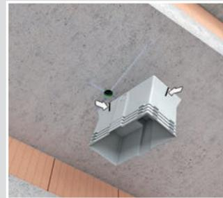
Ausrichtmarkierungen für die Leuchtenposition und den Befestigungspunkt.
