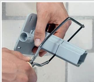
Träger durch Absägen auf benötigte Länge kürzen, integrierte Massangabe sorgt für exaktes Ablesen des Masses.
