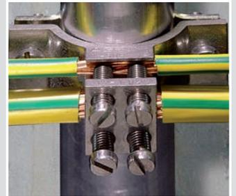
Grosse Kontaktfläche des Leiters durch zwei Kontaktschrauben auch bei der Doppelklemme für den Anschluss zweier Potentialausgleichsleiter.
