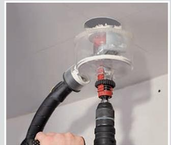
Sobald das Material durchtrennt ist, Bohrmaschine sofort ausschalten. Erst nach Stillstand den VARIOCUT zurückziehen und das ausgeschnittene Material entfernen.
