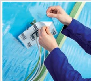
Bevor die Manschette aufgeklebt werden kann, muss sichergestellt werden, dass der Untergrund staubfrei ist. Anschließend Schutzfolie abziehen,...
