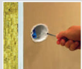
Dose mit den zwei vormontierten FX4-Schrauben befestigen.
