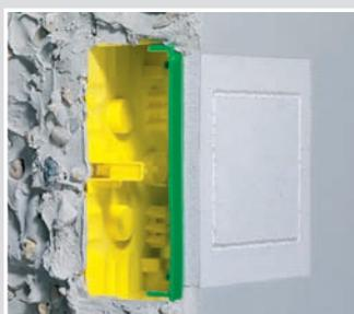
Das einbetonierte Gehäuse mit dem flächenbündigen Abschluss der Mineralfaserplatte. Die Nut in der Mineralfaserplatte geben den maximalen Montagebereich an.
