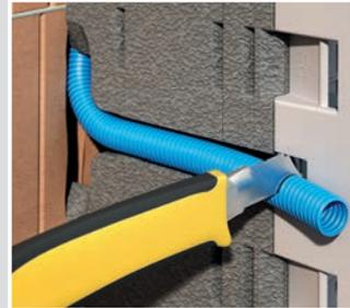
Das Rohr in die seitliche Führung drücken und ablängen.
