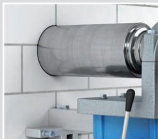
Installationsöffnung je nach Wandstärke mit einem Kernbohrer 150 mm erstellen.
