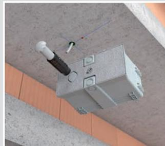
Rohreinführung ausbrechen oder passgenaue Leitungseinführung für die luftdichte Installation erstellen, z.B. mit dem KAISER Universal-Öffnungsschneider (1085-80).
