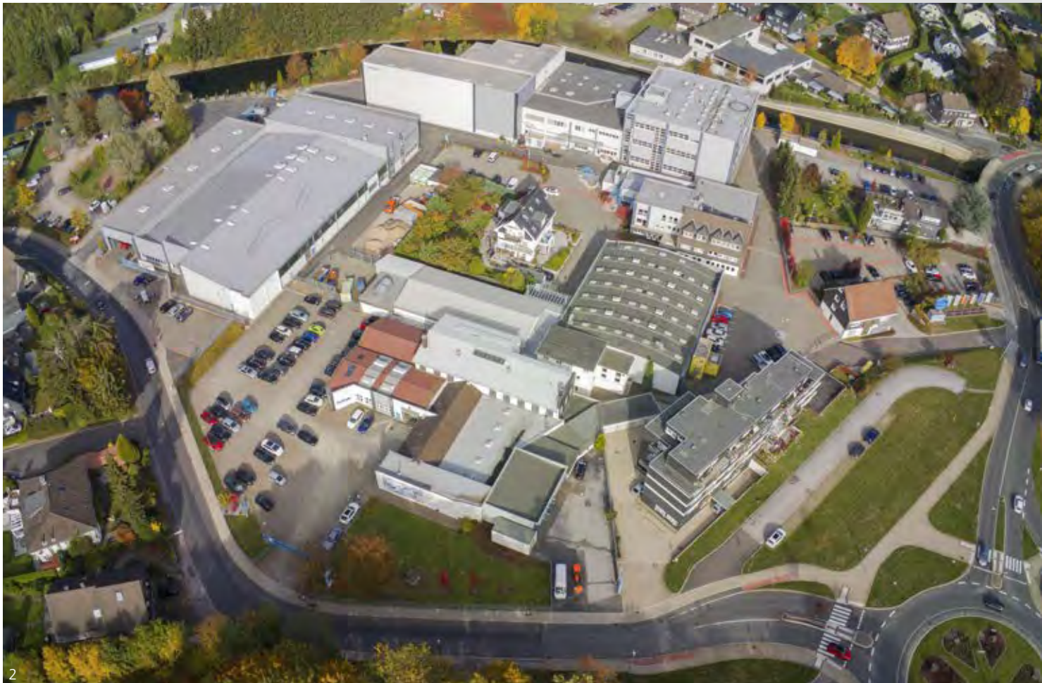
Abb. 1 – Werk 2 – PFLITSCH-Kompetenzzentrum für Kabelkanäle Fig. 1 – Plant 2 – PFLITSCH competence centre for cable trunking
