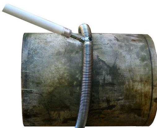
Рис. 25. Подготовленный к проведению контроля пружинный электрод с подсоединенными захватом и удлинителем
